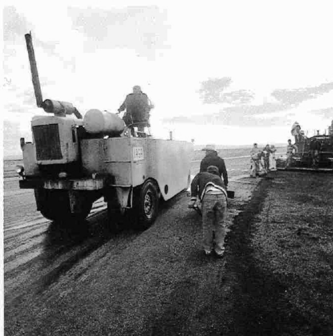
Una de las pistas en construcción; abajo, vista aérea del aeropuerto.
