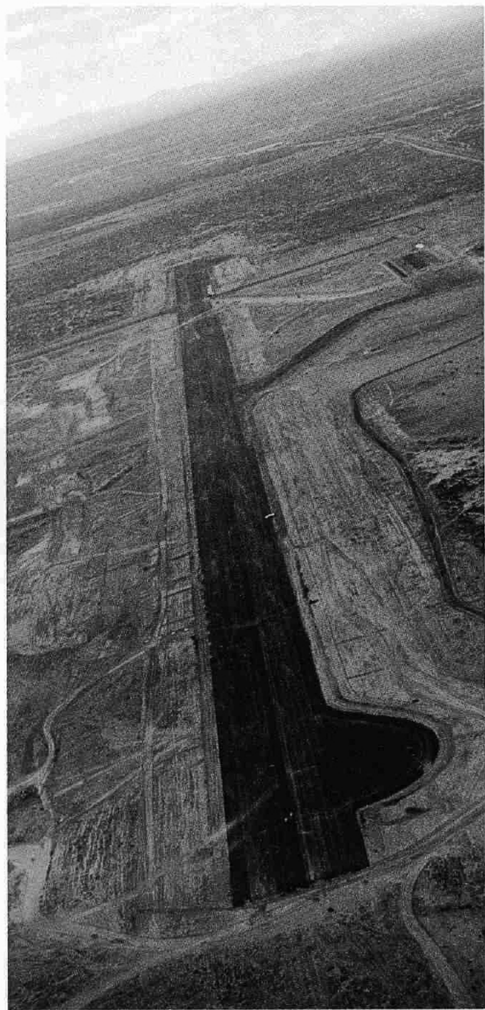
Secuencia fotográfica en que se aprecian tres aspectos de las obras de IASA en el aeropuerto de San Luis Potosí.
