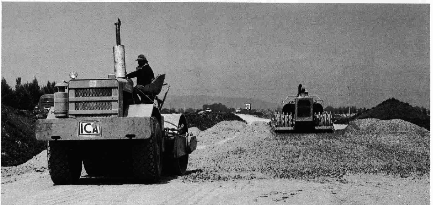
Maquinaria de ICA en los trabajos de la autopista Irapuato-Salamanca.
